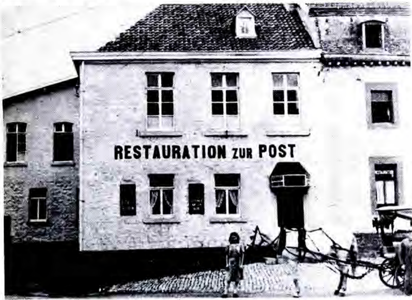
Zu den ältesten Gebäuden des Eupener Vorortes Kettenis gehört zweifellos diese hier abgebildete »Restauration zur Post«. Bekanntlich wurde dieses Gebäude vor einigen Jahren von einer Feuersbrunst zerstört und seitdem »ziert« diese häßliche Ruine das Dorfzentrum. Pferd und Karren gehörten dem damaligen Gemüsehändler Karl Orban
